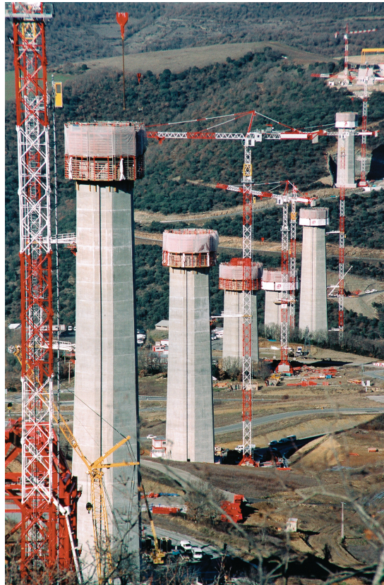
Fig. 1-5. Viaductul de la Millau, Franța, 2004. Pilele de beton au până la 246 metri înălțime
