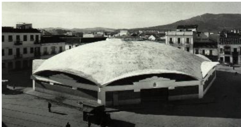
Fig. 1-3. Piața acoperită din Algeciras (E. Torroja, 1933, 48 m deschidere)
