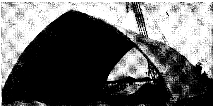
Рис. 4. Железобетонный свод для пункта хранения сельхозтехники
