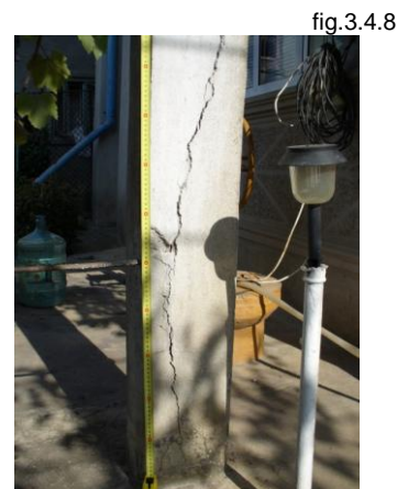
Fisuri longitudinale la un stâlp din beton armat
